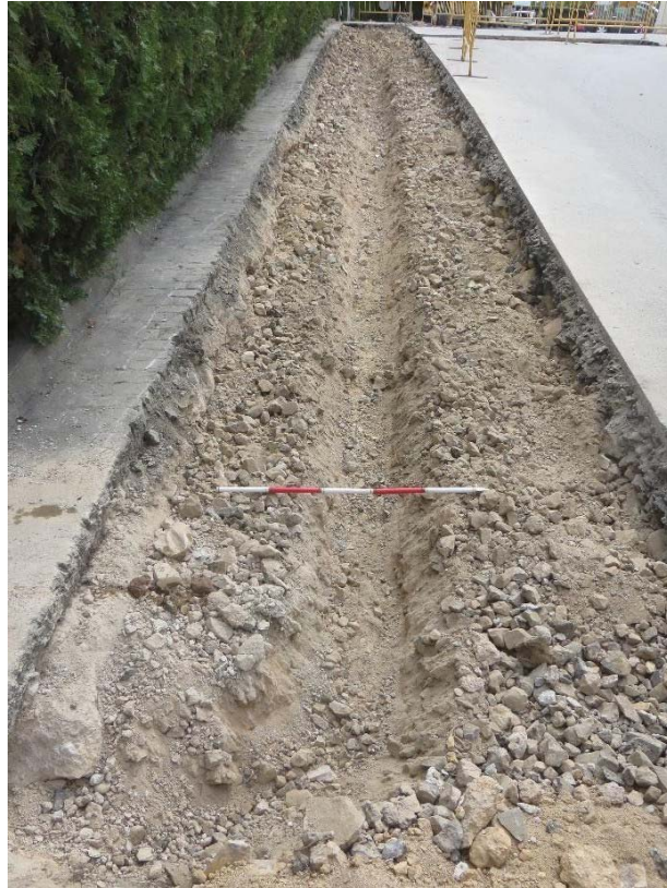
Fig. 18: Imatge del tram principal de la Rasa 2 un cop finalitzada la seva obertura.
